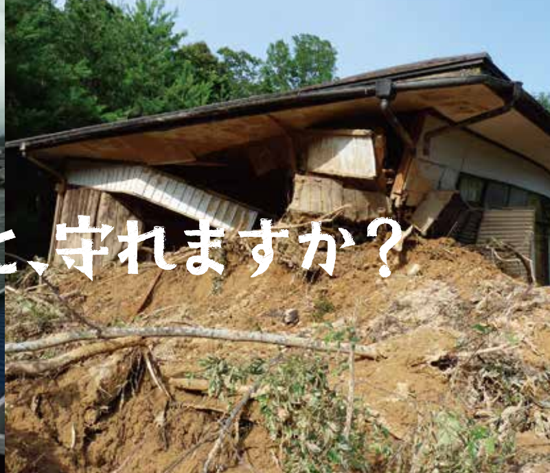
平成21年7月21日の大雨災害の小野地区 提供:宇部市
