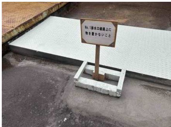
排水溝の蓋の周囲に高さ5cmの縁石を設けた。また、No.1排水溝経路上に物を置かないよう注意喚起する掲示を設置した。（対策後）
