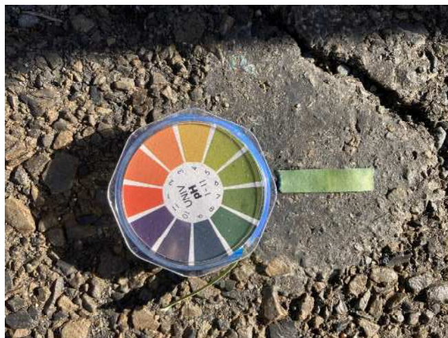
(4) リトマス試験紙で中性であることを確認し 洗浄完了
