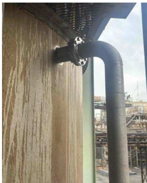
タンク上より30cm下に呼出しノズルを設置した。
