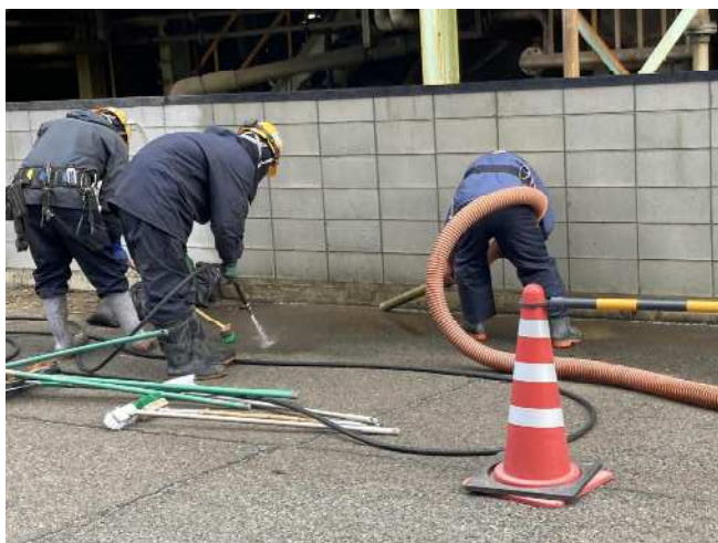
(3) アスファルトの路面を高圧洗浄とデッキ ブラシで洗浄
