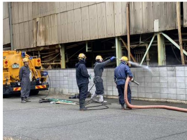
(2) 山村産業が高圧洗浄機で壁を洗浄 高吸引車で洗い水(廃水)を吸引
