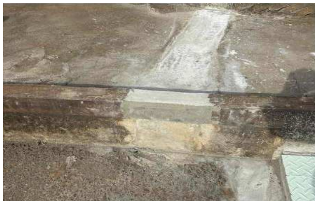
縁石を修理した（対策後）
