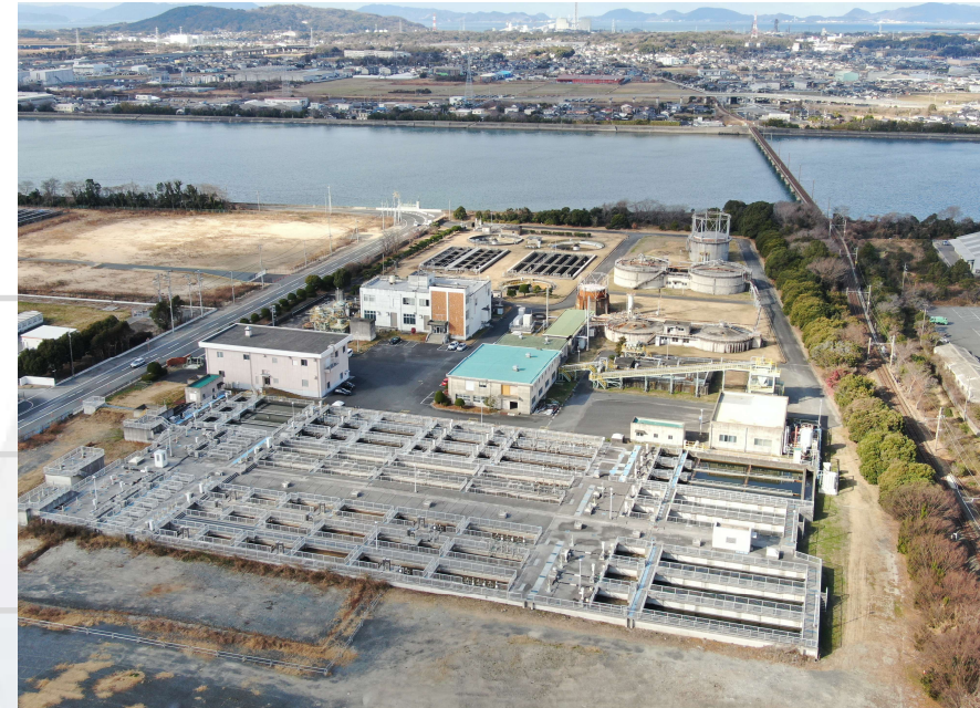
宇部市西部浄化センター全景
