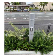
コンセントポール
