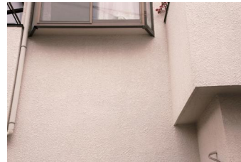
健全な外壁（ひび割れ等がない）
