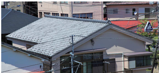
健全な瓦屋根
