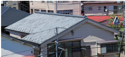
健全な瓦屋根
