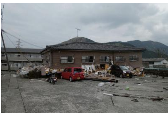
写真 14 倒壊した木造アパート
