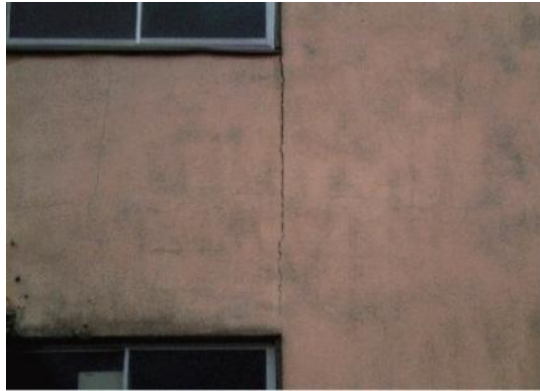
写真Ⅱ.2.2.5 モルタル外壁に生じた大きなひび割れ
