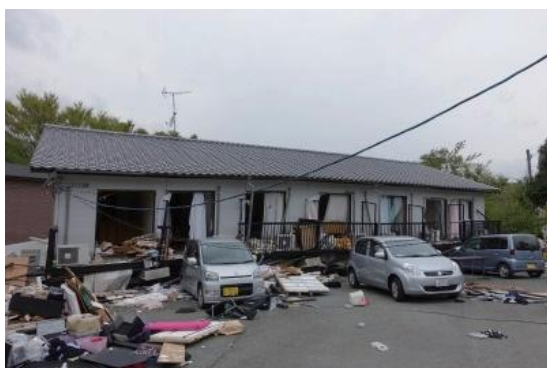
写真 12 倒壊した木造アパート
