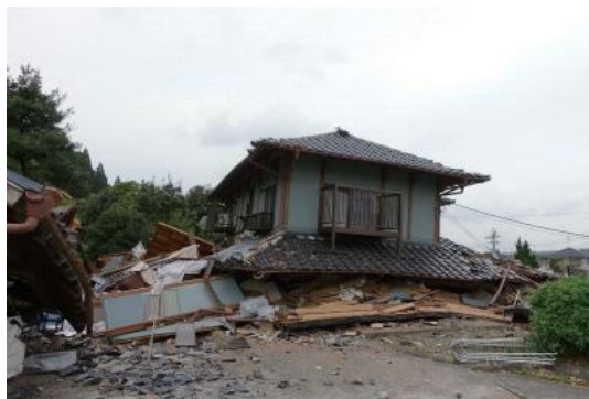
写真9 倒壊した木造住宅
