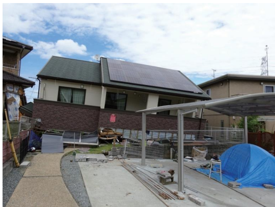
写真4 倒壊した木造住宅
