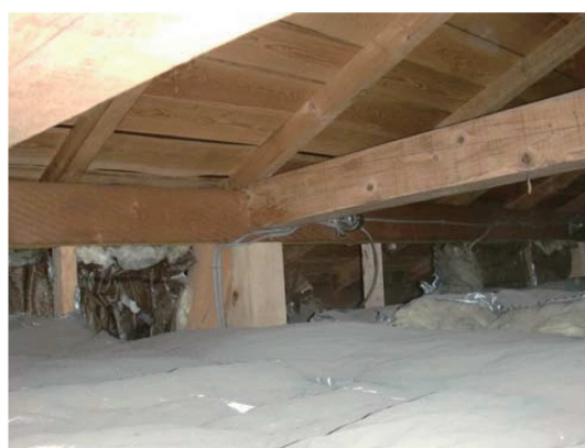
写真Ⅱ.2.2.2 柱頭接合部の例 (金物が使われていない例)
