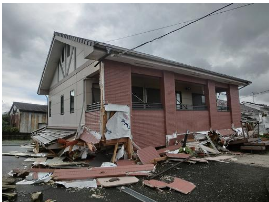
写真6 倒壊した木造住宅
