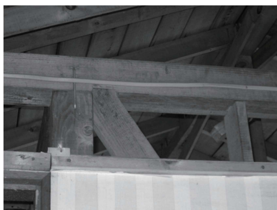
写真Ⅱ.2.2.3 柱頭接合部の例 (金物が使われていない例)
