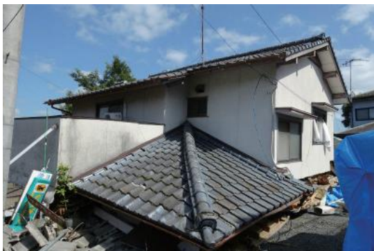
写真2 倒壊した木造住宅
