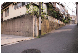
擁壁や坂 に面する
