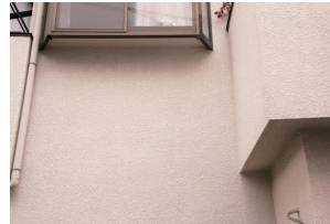
健全な外壁（ひび割れ等がない）
