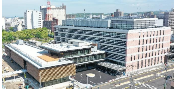
市役所本庁舎（令和7年5月現在）
