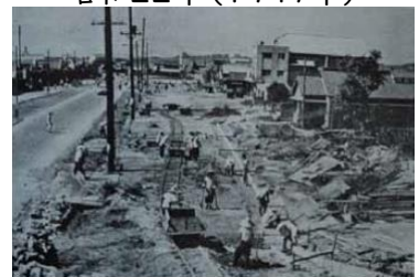
■ 常盤通りの復興作業 昭和22年(1947年)
