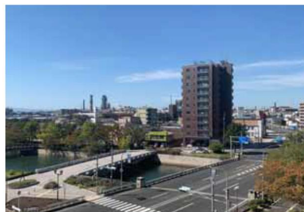
■令和元年(2019年)の新川大橋の街並み
