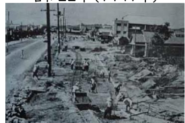
■ 常盤通りの復興作業 昭和 22 年(1947 年)
