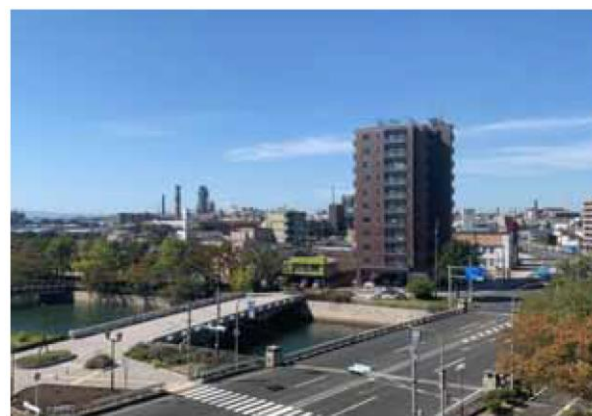
■令和元年（2019年）の新川大橋の街並み
