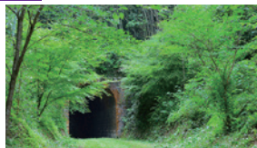
大棚トンネル
