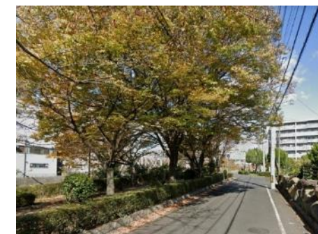
架線への接触（支障木）
