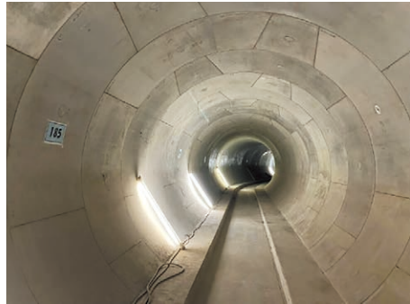
地下13mの下水道管(直径3.5m)
