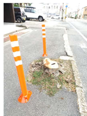
伐採後の注意喚起の例
