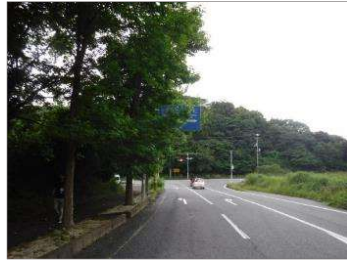
道路標識の視認性阻害
