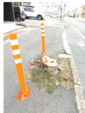
伐採後の注意喚起の例
