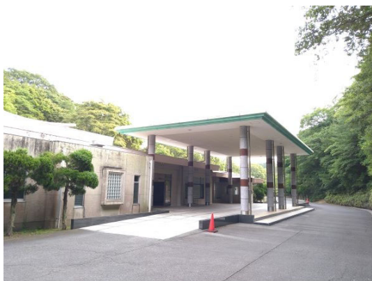
③ 現火葬場入口
