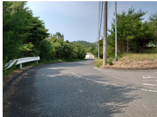
② 市道高嶺請川線との接続部
