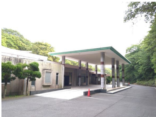
③ 現火葬場入口
