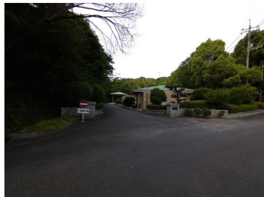
④ 現火葬場の門
