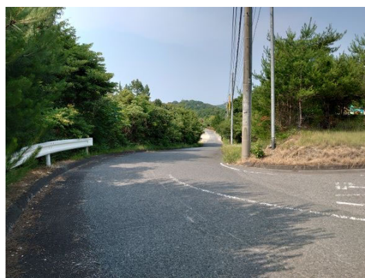
② 市道高嶺請川線との接続部
