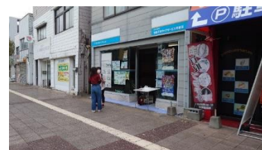
管理事務所及び備品収納庫
