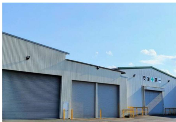
ボイラー「外観写真」の例
