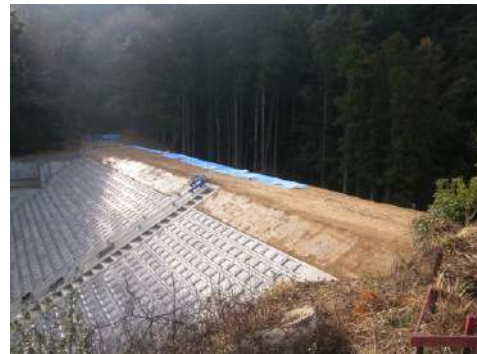
[ため池の整備・改修(完成後)]
