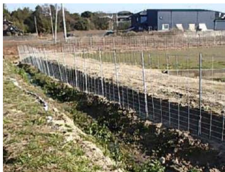
[ワイヤーメッシュ柵の設置]
