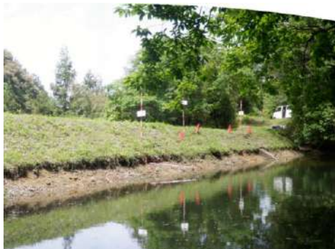
[ため池の整備・改修(着手前)]
