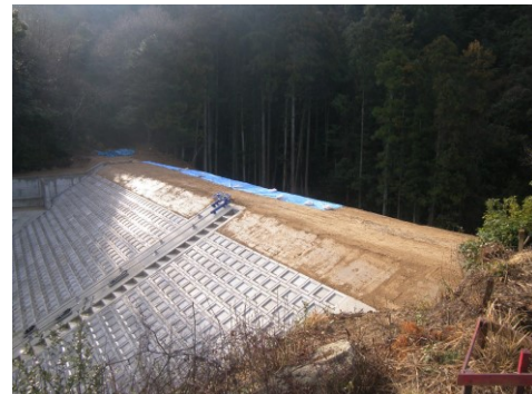
[ため池の整備・改修(完成後)]
