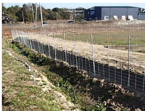
[ワイヤーメッシュ柵の設置]
