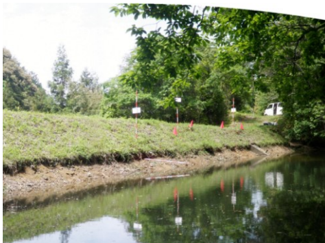
[ため池の整備・改修(着手前)]
