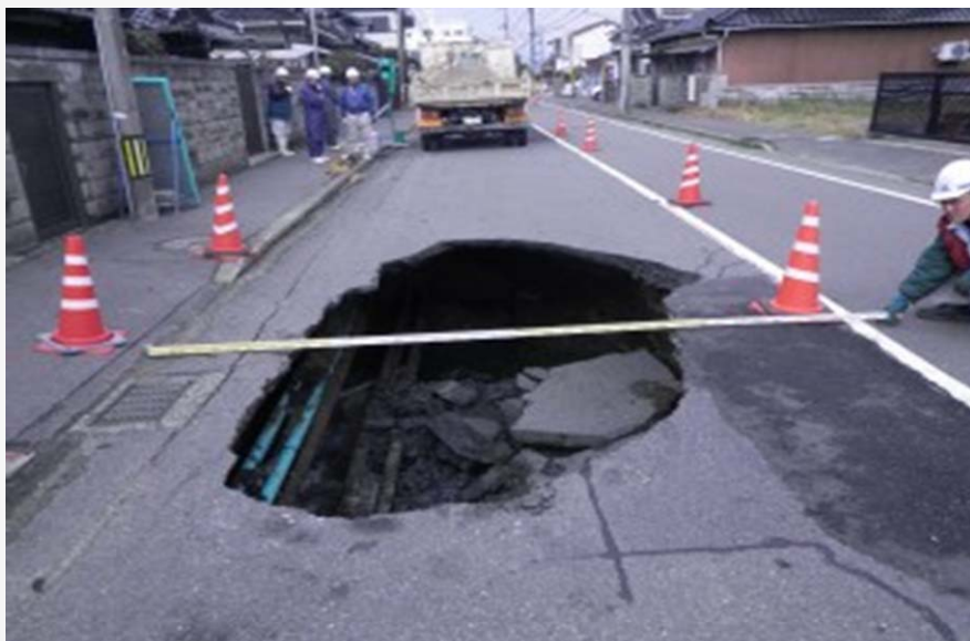
平成23年3月に発生した 宇部市居能町の陥没（直径約2.0m）
