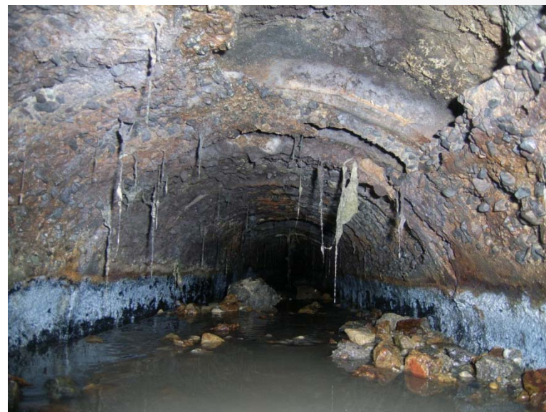
宇部市居能町の陥没 （管渠の劣化状況）
