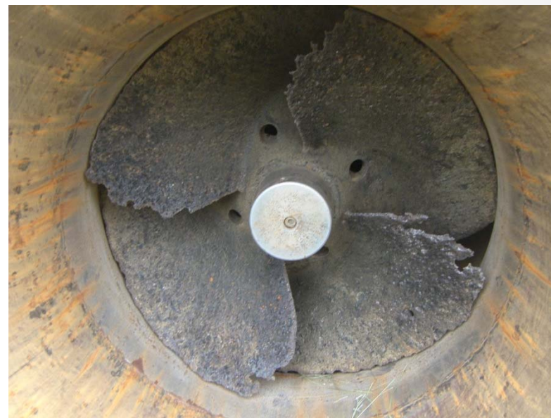
雨水ポンプの劣化状況（拡大写真）
