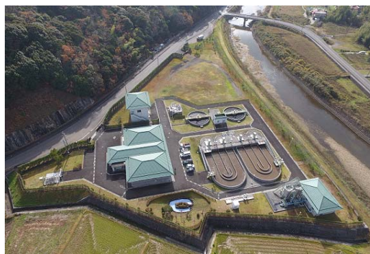
楠浄化センター
