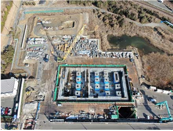
玉川ポンプ場（躯体）
