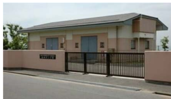
岐波ポンプ場
