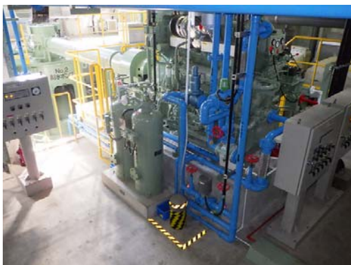
八王子ポンプ場雨水ポンプ更新
