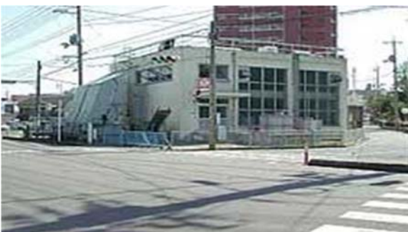
塩田川ポンプ場
