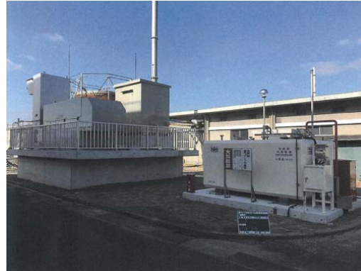
西部浄化センター電気設備更新
