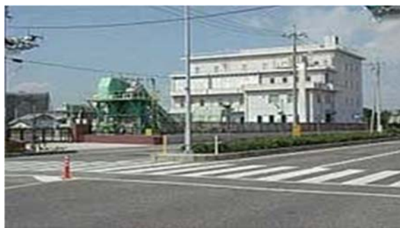
小串ポンプ場
