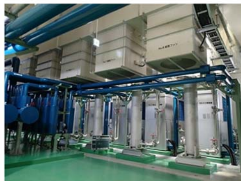
消化ガス発電施設
