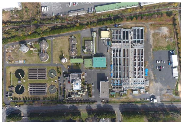
西部浄化センター
