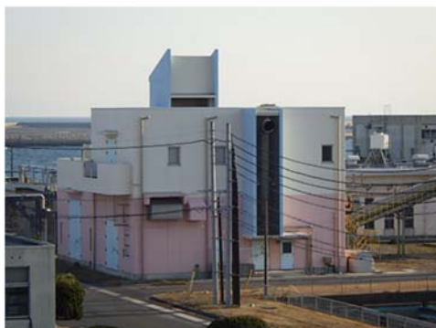
東部浄化センター 電気棟
