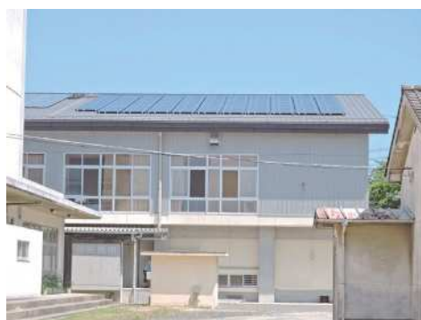
災害に備えた避難所の整備（体育館）
