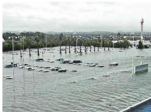
平成11年高潮被害（宇部空港）
