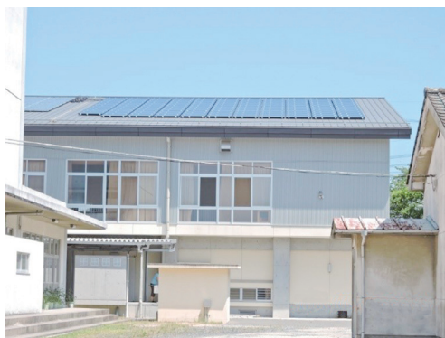
災害に備えた避難所の整備（体育館）
