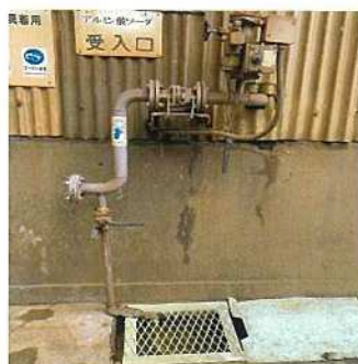
残液抜き配管切断前
