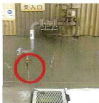
残液抜き配管切断後
