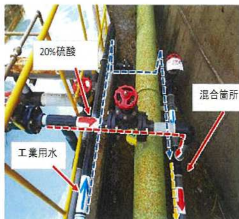
【写真4】改造箇所: 20%硫酸と工業用水を混合し 希硫酸添加設備①へ送液
