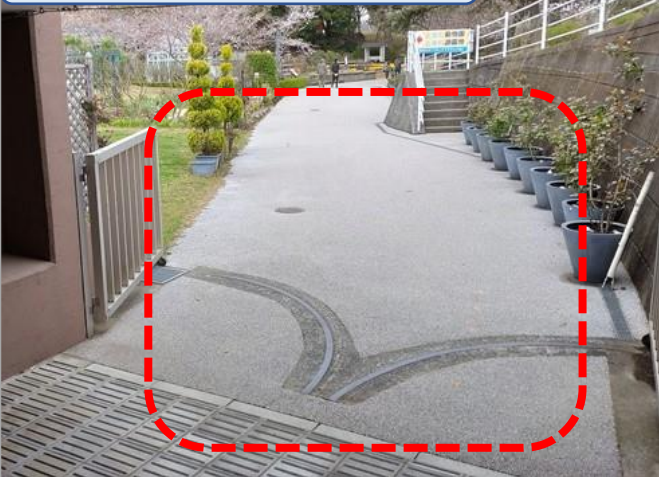
【中央入口(地下道側)】
