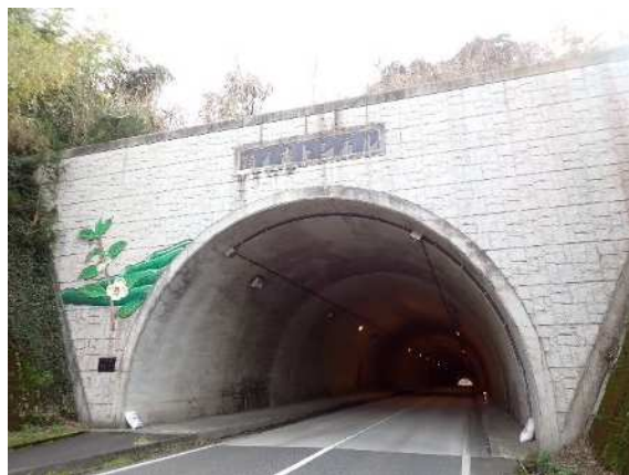
写真-1.1 点検対象箇所（坑門）
