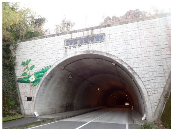
写真-1.1 点検対象箇所（坑門）
