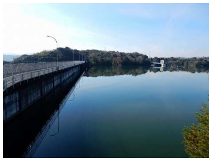
8 湖面側から見た堤体
