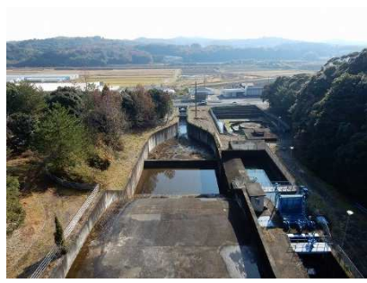
10 堤体上から見た洪水吐
