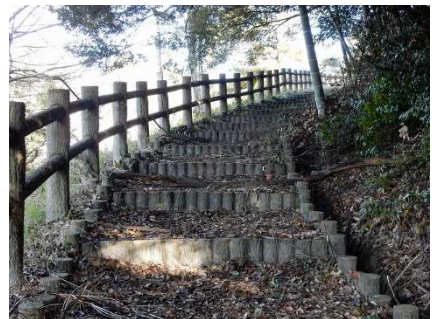
5 堤体上部へ徒歩で登れる道
