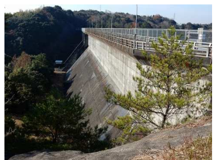
6 上部から見た堤体
