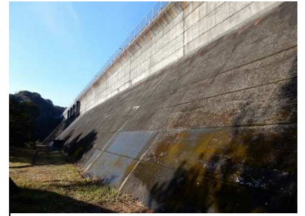
4 真下より見上げた堤体
