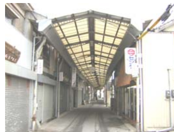
▲シャッターが閉まったままの空き店舗
