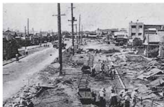
常盤通りの復興作業 昭和22年(1947年)
