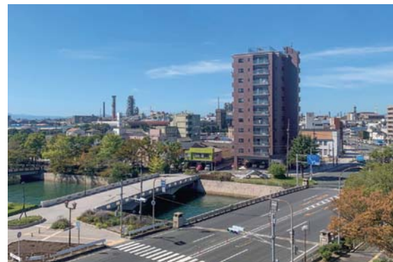
令和元年(2019年)の新川大橋の街並み
