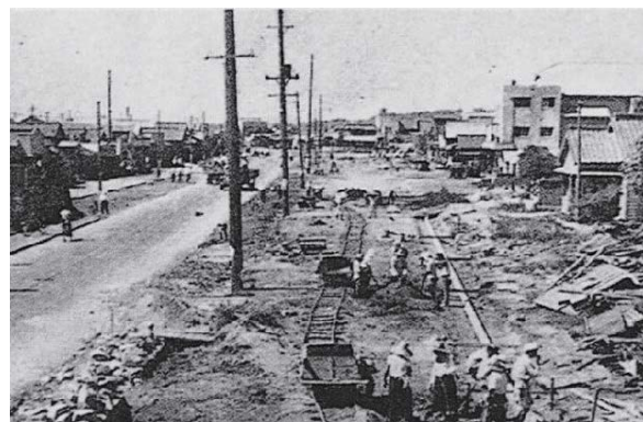
常盤通りの復興作業 昭和22年(1947年)
