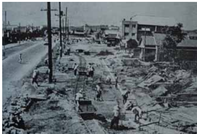
常盤通りの復興作業 昭和 22 年（1947 年）
