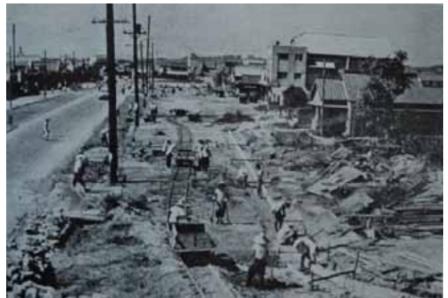
常盤通りの復興作業 昭和22年(1947年)
