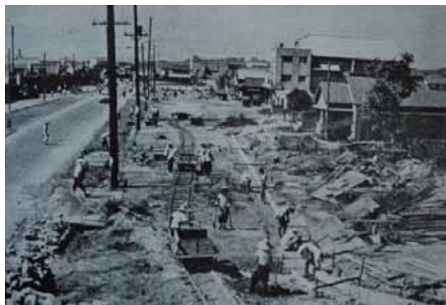
常盤通りの復興作業 昭和 22 年（1947 年）
