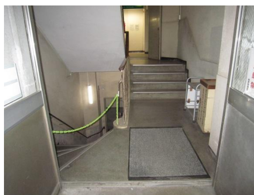
【 本館1階 北側出入口 】
