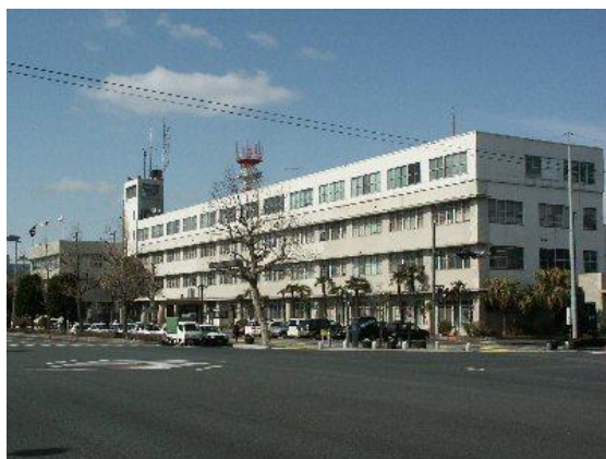
【 市役所本庁舎 本館 】
