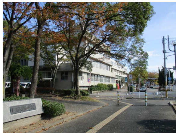
真締川公園(左)と常盤通り(右)に面する庁舎
