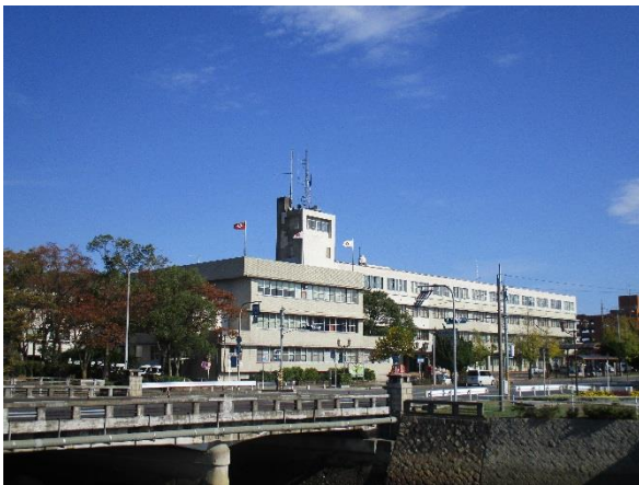
常盤通りを挟んだ庁舎全景
