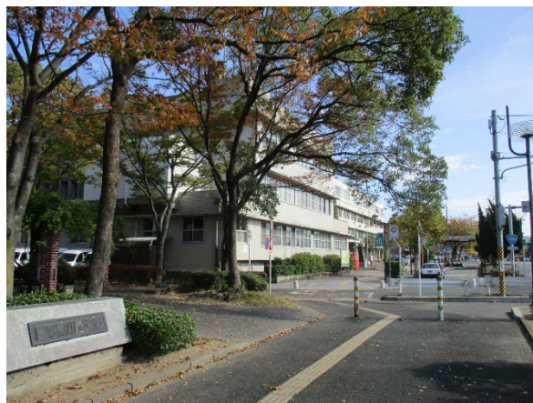
真締川公園(左)と常盤通り(右)に面する本庁舎
