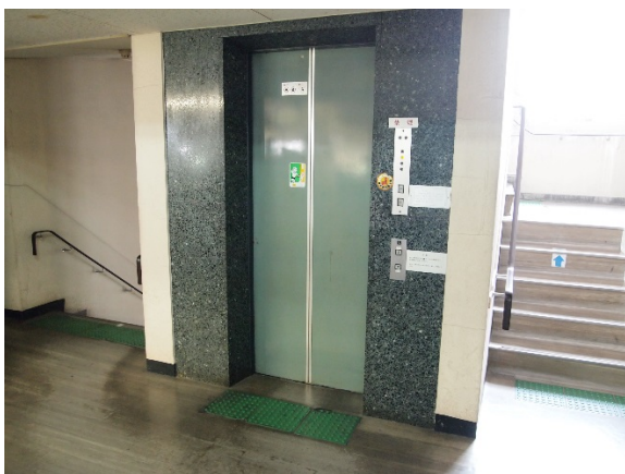
出入口幅の狭いエレベータと急勾配の階段
