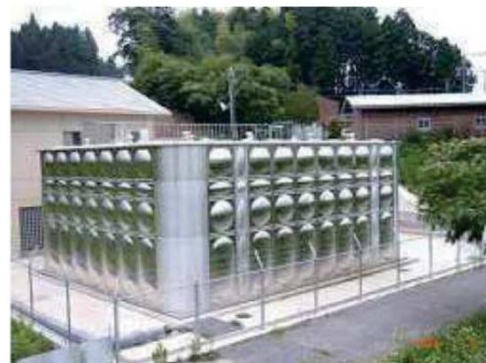
加圧給水ポンプ方式は、高置水槽方式に比べ、ランニングコストが若干高いが、地震時の転倒など災害時の危険性が低い。
