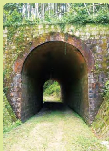
④大畑トンネル
