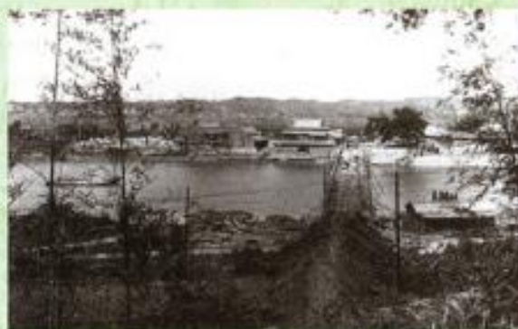
昭和9年架設の初代沖ノ旦橋(工事中)
