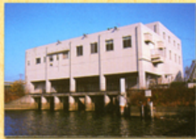
29 中川排水機場
