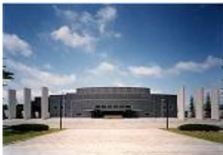
国の重要文化財 渡辺翁記念会館 1937年（昭和12年）竣工 村野藤吾設計の傑作として国内外に 広く知られた建造物です
