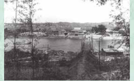
昭和9年架設の初代沖ノ旦橋 (工事中)
