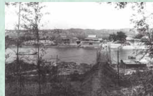
昭和9年架設の初代沖ノ旦橋(工事中)
