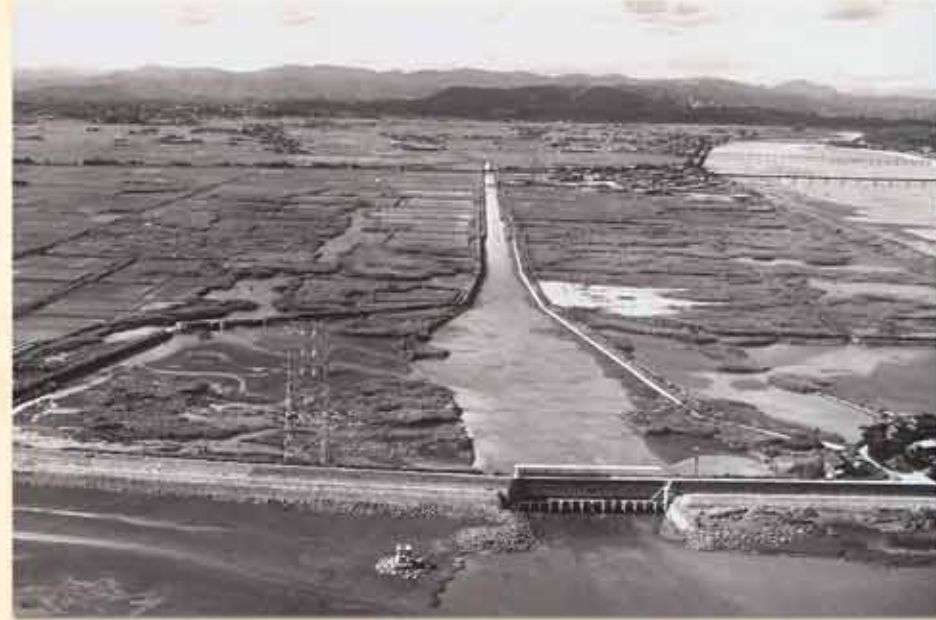
(昭和34年8月、樋門改修直後)
