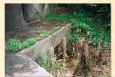
21 波多野開作樋門
