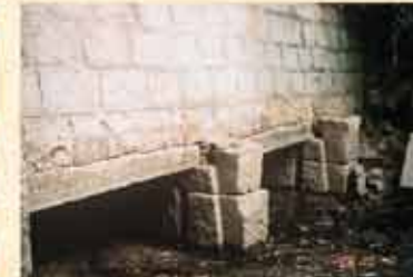
(外側) 28 開作四挺唐樋跡
