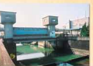
25 梅田川防潮水門と排水機場
