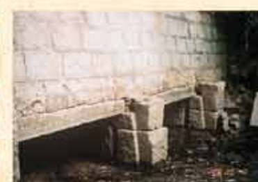
(外側) 28 開作四挺唐樋跡
