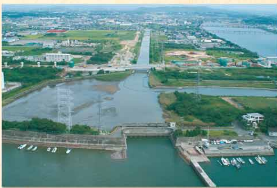
(小島樋門から中川、厚南平野を望む)
