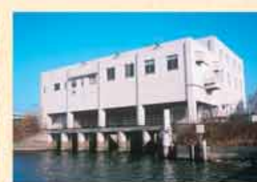
29 中川排水機場
