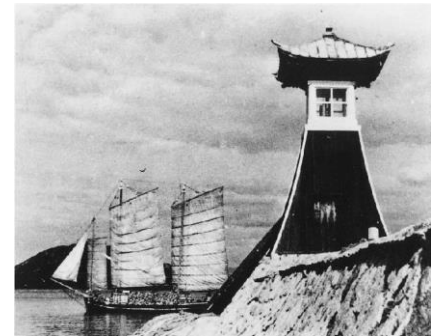
丸尾波戸灯炉堂（昭和 16 年）
